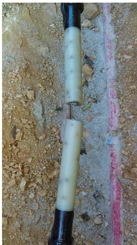
Slika 6. „Nezdravo“ stanje izolacije
